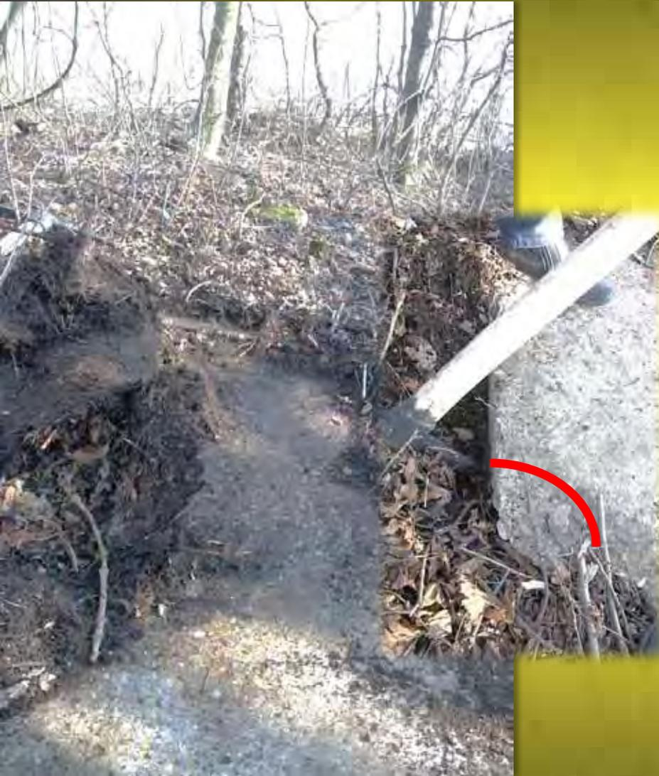
Am 12.3.2011 unternahm der Autor eine Grabung am westlichen Rande der Stellung. Das Ergebnis: Die ursprünglich für eine Geschützstellung gehaltene Fläche stellte sich, was die Betonstärke betrifft, nicht für eine Flak geeignet dar (15cm). Auf dem linken Bild ist eine, 2 cm dicke Platte erkenntlich. In der Bildmitte sieht man eine dicke Betonplatte, die an den vier Ecken halbrunde Ausnehmungen hatte; sie war z. B. für einen Generator geeignet.
