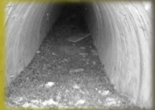
**Im Steinbergerbachtal wurden zwei Splitterschutzunterstände nach einem neuen Verfahren zur Produktion von Halbbetonschalen für die hier Beschäftigten errichtet.**
